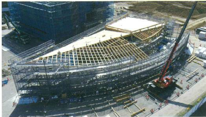
新技術研究所「ICIラボ」ネスト棟(木造)の建方
