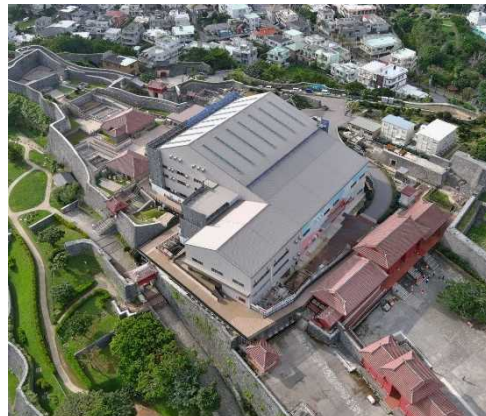
首里城正殿工事現場（素屋根、木材倉庫・原寸場設置）の状況
