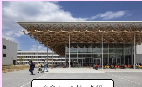
音楽ホール棟 外観
